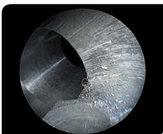
Prüfung einer Bohrung auf Grاتفreiheit
